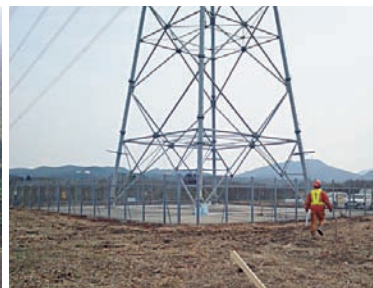
切土工事安全管理
