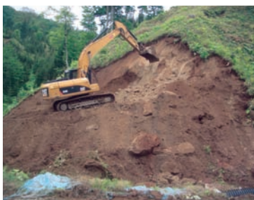
法面工事安全管理
