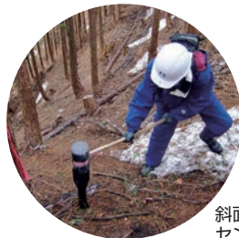
砂防工事安全管理
