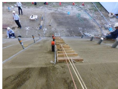
設置したセンサ杭
